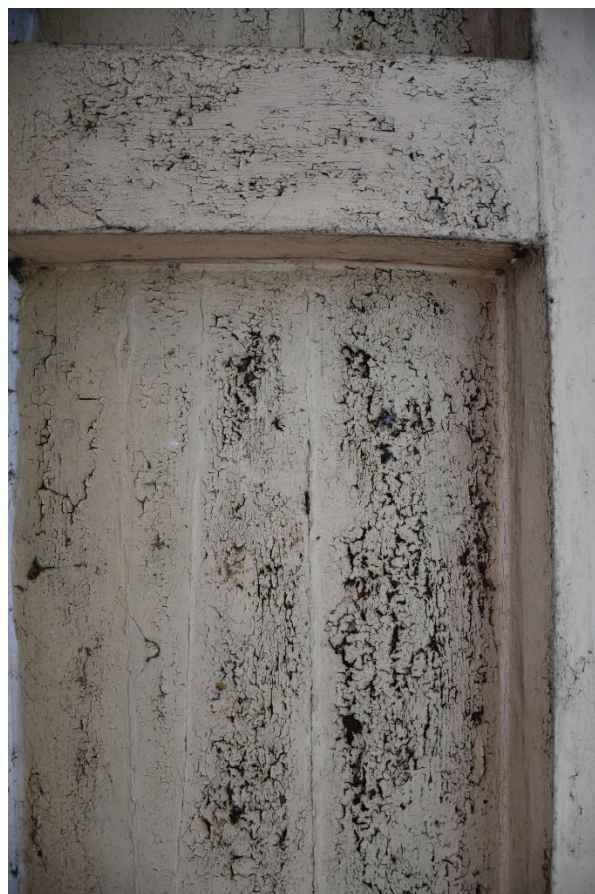
Obrázek 9 Intenzivní degradace povrchových úprav dřevěného podhledu a nosného trámku podhledu SV stěny ochozu.
