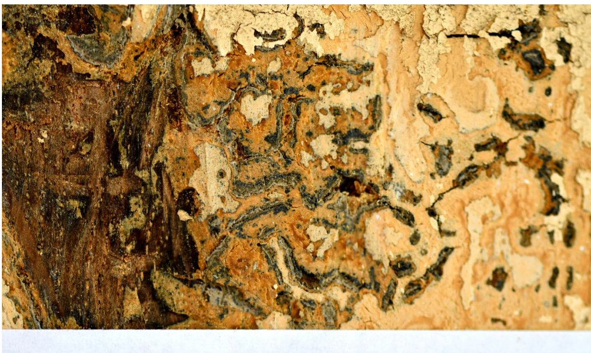
Obrázek 6 Sondážní stratigrafický průzkum, sonda č. 2 – prostřední trám podhledu SV stěny.
