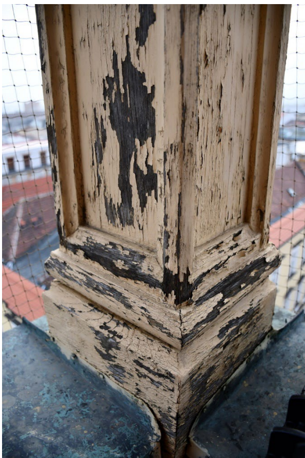
Obrázek 8 Degradace povrchových úprav sloupku ve východním nároží ochozu.
