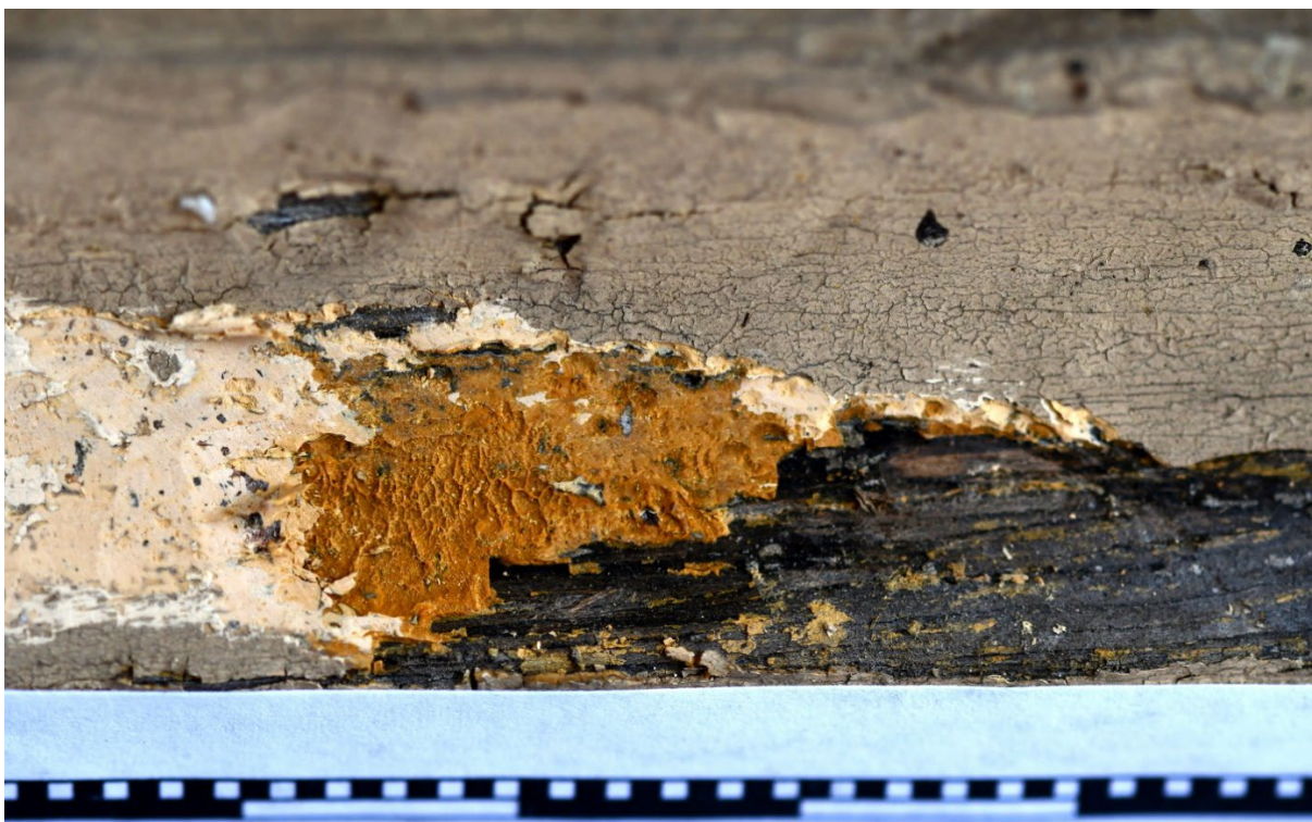
Obrázek 5 Sondážní stratigrafický průzkum, sonda č. 1 – prostřední sloupek SV stěny.
